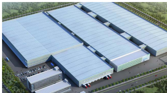
Завод электронных подвесок SENSEN, Чучжоу (Завод III)
